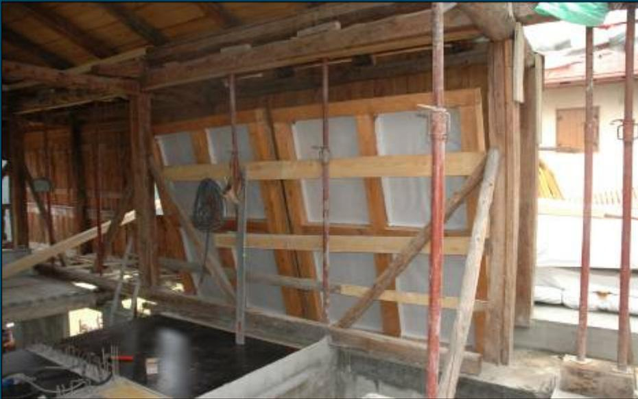
**Consolidamento delle strutture lignee perimetrali mediante inserimento di telai in lamellare**
