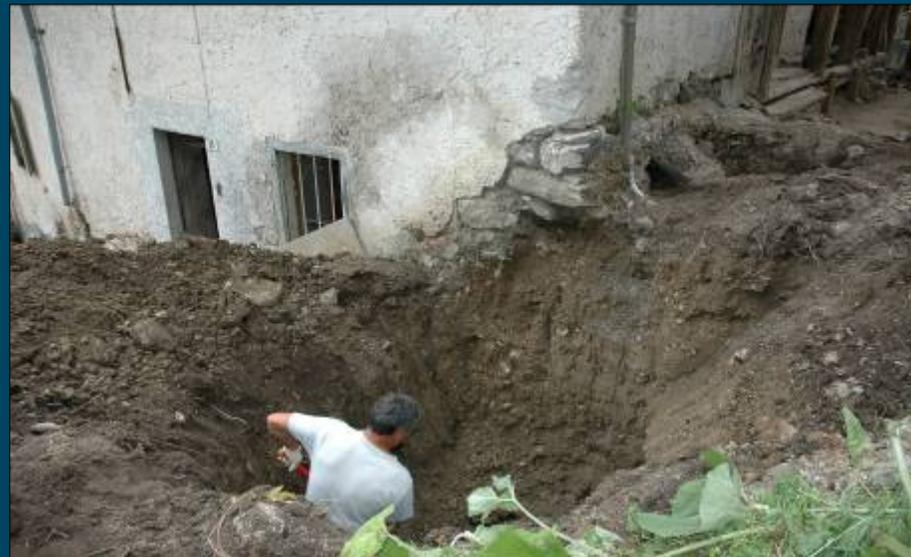
**ricostruzione di fondazioni totalmente assenti in parti di muratura realizzate controterra;**
