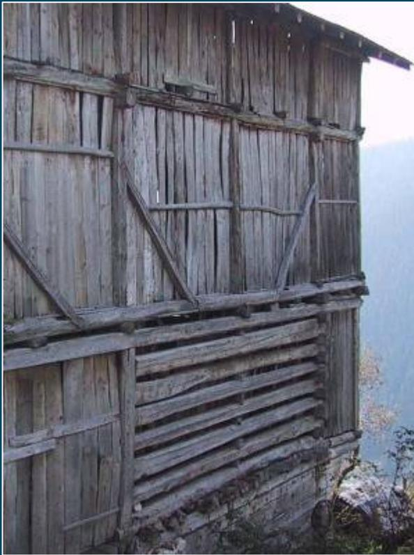
Negli edifici rurali post ottocenteschi, l'elevazione veniva realizzata attraverso il sistema costruttivo dell'assito verticale in legno di larice fissato su una intelaiatura lignea il legno d'abete. Tale sistema costruttivo, largamente diffuso, ha tendenzialmente sostituito quello del blockbau e la sua diffusione è stata principalmente determinata dall'evoluzione delle tecniche di lavorazione del legno che ha consentito la realizzazione di "breghe" con evidente risparmio di materiale ligneo.
