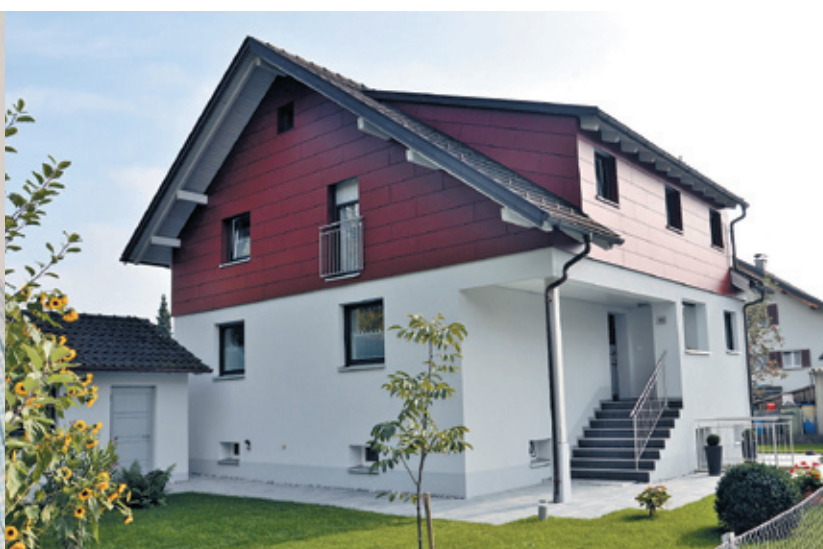
Dieses Haus (Baujahr 1955) erfuhr eine wertsteigernde Sanierung.
