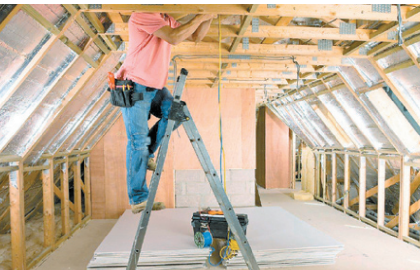
Fachmännische Ausführung garantiert eine erfolgreiche Sanierung.
