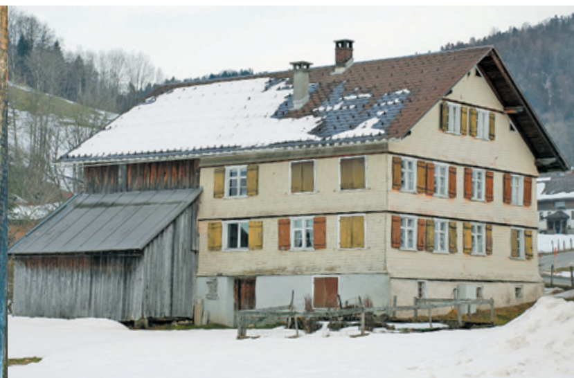
Ungedämmte Häuser heizen zum Dach und zur Fassade hinaus.
