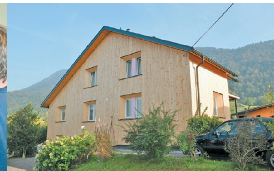
Baujahr 1964: Das Haus wurde zur Betriebskostensenkung gut verpackt.
