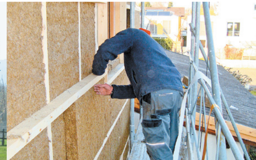
Auch die Grasdämmung wird in Platten aufgebracht.
