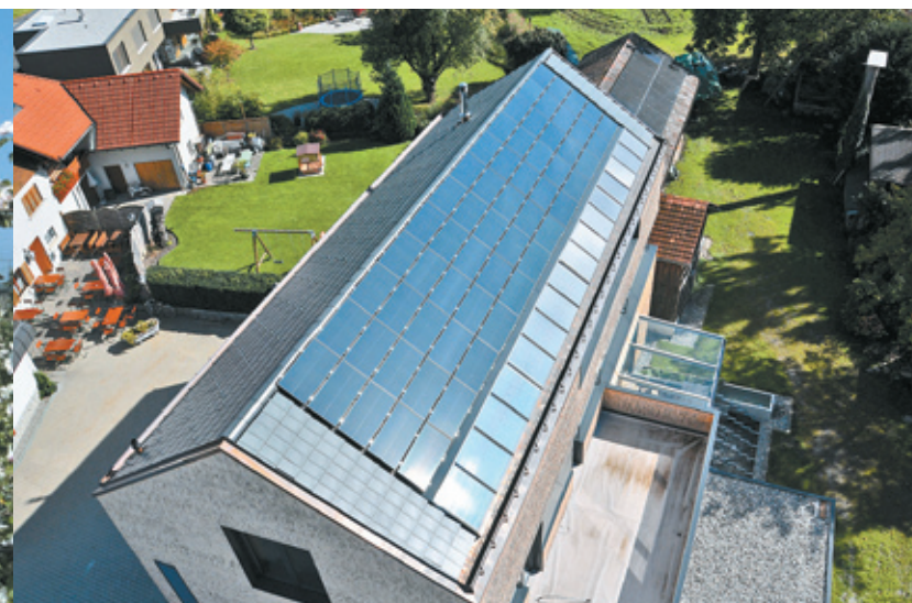
Der Strom für die gesamte Haustechnik wird mit dieser Fläche erwirtschaftet.
