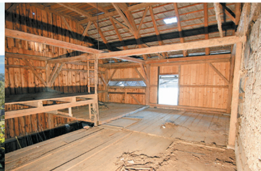
Der Stadel eines alten Rheintalhauses vor der Sanierung.
