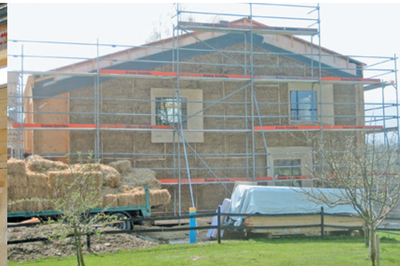
Dieses Objekt im Bregenzerwald wurde mit Strohballen gedämmt.
