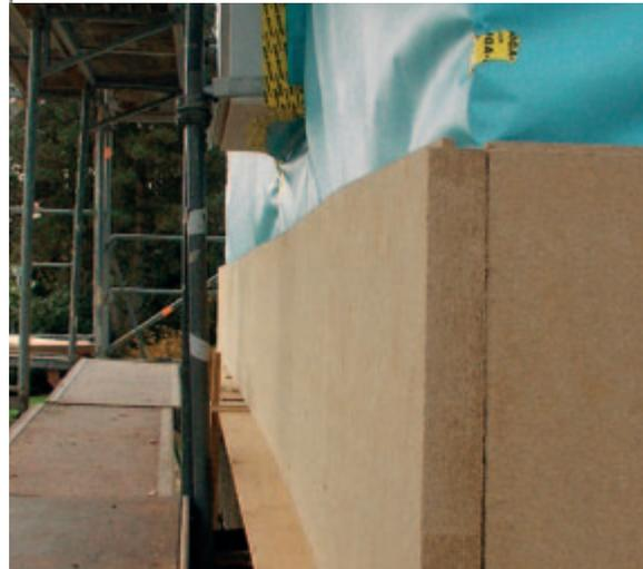
Wer die Fenster dämmtechnisch an die richtige Stelle setzen möchte, muss sie an die Dämmebene oder in die Dämmebene setzen. Dadurch werden die schießscharartigen Fensterlaibungen verhindert.
