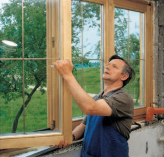
Ältere Fenster sollten, wenn sie nicht erneuert werden, von einem Fachmann neu eingestellt und schadhafte Dichtungen erneuert werden.
