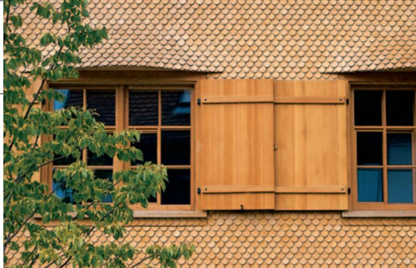
Fenster sind der sensibelste Bauteil eines Gebäudes. Ihre Sanierung bedarf großes Fingerspitzengefühl. Sie bestimmen wesentlich den Energiehaushalt eines Wohnhauses.
