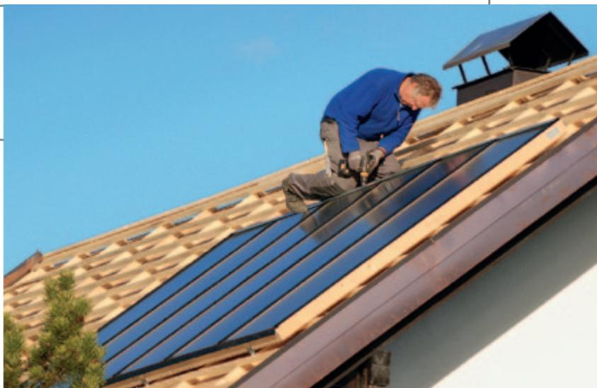
Beim Dach(neu)eindecken bieten sich gute Voraussetzungen: Kran und Gerüst, Spengler und Dachdecker sind da. In ein paar Stunden sind die Kollektoren im Dach fix und fertig integriert.
