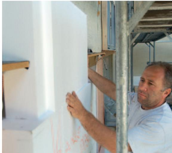
Außenwanddämmungen mit einem guten Dämmwert sind mehr als 14 cm dick. Weit verbreitet sind Kompaktdämmfassaden aus Polystyrolplatten.
