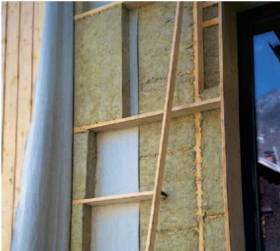
Bei sogenannten vorgehängten Fassaden werden oft Dämmstoffe aus Glas- oder Steinwolle eingesetzt. Ein Windpapier verhindert die Durchströmung des faserigen Dämmstoffes.
