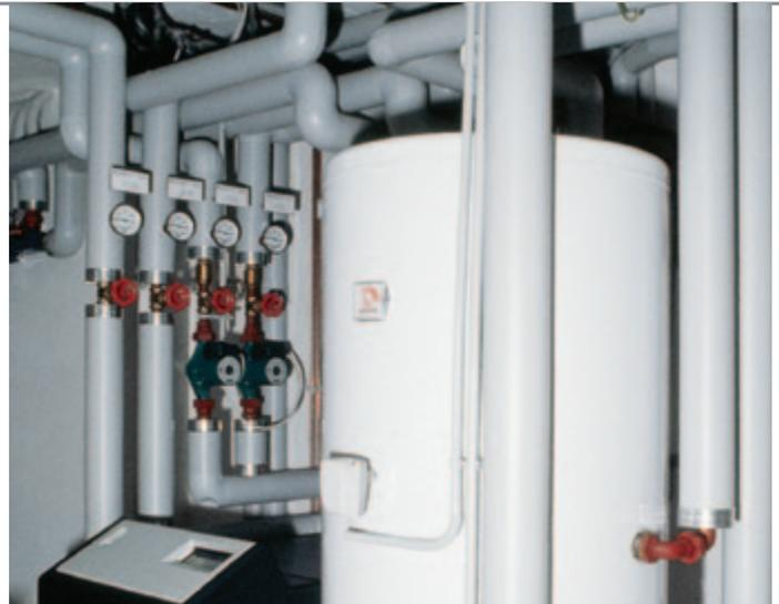
Die Verteilerverluste und Speicherverluste werden unterschätzt. Leitungen, die Wärme transportieren, müssen ausreichend und durchgehend gedämmt sein. Bei der Speicherdämmung auf die größtmögliche Dämmdicke achten.
