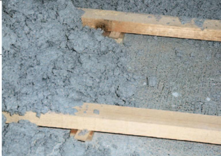
Eine ökologische Art und Weise der Fußbodendämmung ist eine Dämmung mit Zelluloseflocken oder Holzfaserdämmung. Für die Ausflockung benötigt man eine stabile Unterkonstruktion.
