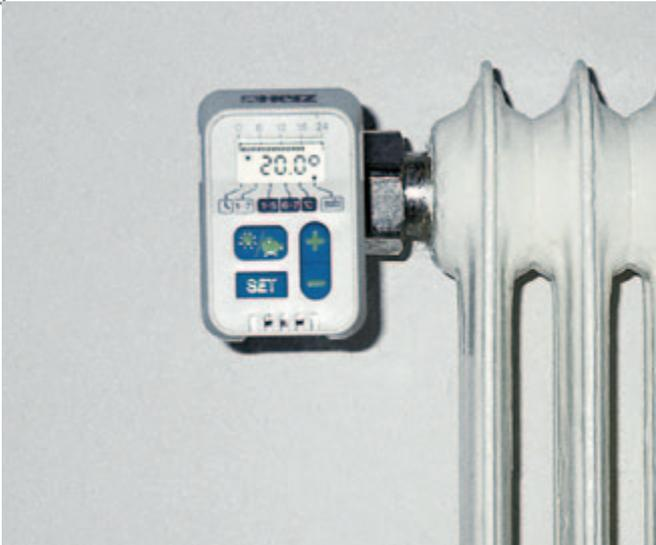
Heizkörperthermostate regeln die Temperatur am Heizkörper so, dass jederzeit eine behagliche Raumtemperatur gegeben ist. Es empfiehlt sich, diese generell nachzurüsten, kombiniert mit einer hydraulischen Einregelung des gesamten Wärmeabgabesystems.
