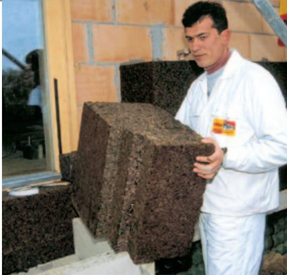
Was für den Neubau gilt, gilt auch für die Sanierung: Sanierung für die Zukunft bedeutet Dämmstärken von 25 – 30 cm.
