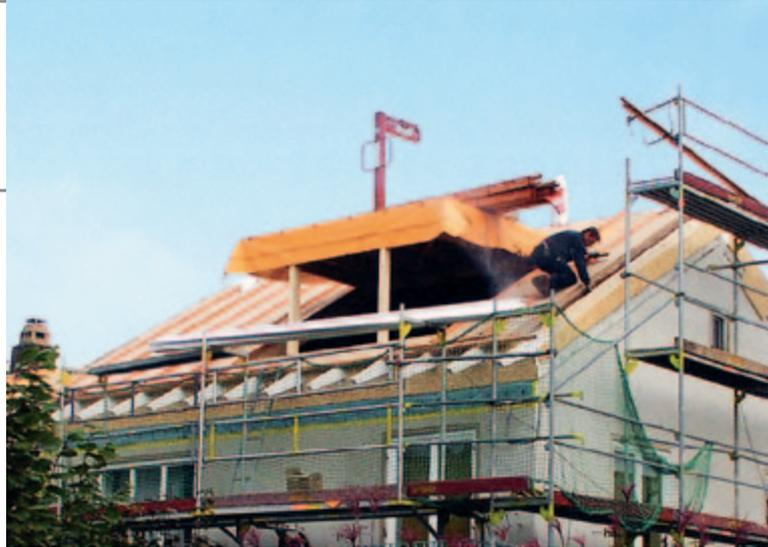
Mehr Wohnraum durch Anhebung des Daches um zwei Ziegelreihen und eine zusätzliche Gaube.
