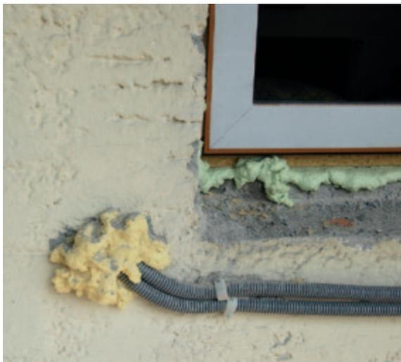
Eine Außenwanddämmung bietet auch die Möglichkeit, dass ohne große Innenbelastungen neue Elektroleitungen unter der Dämmung installiert werden können, sofern die Luftdichtheit nicht darunter leidet. Auch Solarleitungen können so leicht vom Dachraum in den Keller verlegt werden.
