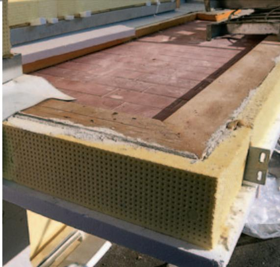
Die klassische Wärmebrücke – die betonierte auskragende Balkonplatte – wirksam zu dämmen ist aufwendig. Auf der Unterseite und auf der Oberseite müssen Dämmmaterialien angebracht werden, um den Wärmebrückeneffekt zu reduzieren.
