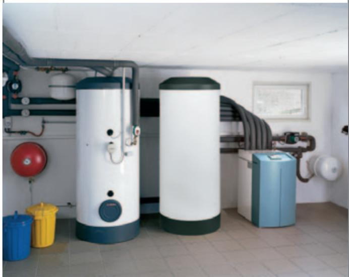
Wärmepumpen sind klein und geräuschlos. Mit guter Gebäudedämmung und bei Grundwasser oder Erdreich als Wärmequelle wird ein effizienter Betrieb erreicht.
