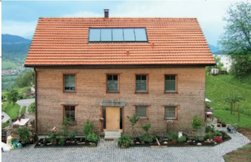
Das umfassend sanierte Wohnhaus mit rund 270 m<sup>2</sup> Bruttogeschossfläche benötigt im Jahr für die Beheizung rund drei Tonnen Pellets.
