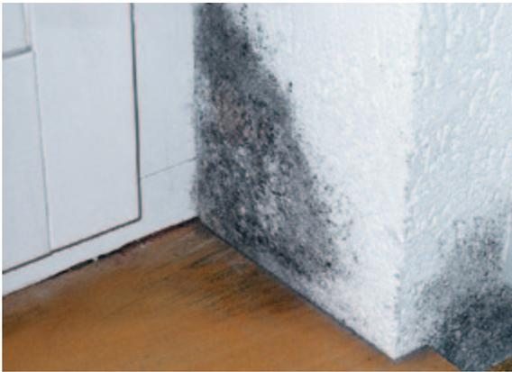
Kalte Gebäudeteile im Innenraum sind oft Ausgangspunkt von Schimmelbildungen. Solche Schäden werden durch gute Dämmung und richtiges Benutzen vermieden.
