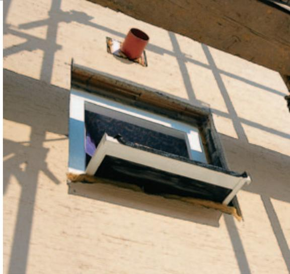
Wer neue Fenster nicht in die Dämmebene setzen kann, muss dafür sorgen dass die Laibungen gut gedämmt werden können. Dafür ist ein Ausbrechen der Wand notwendig.
