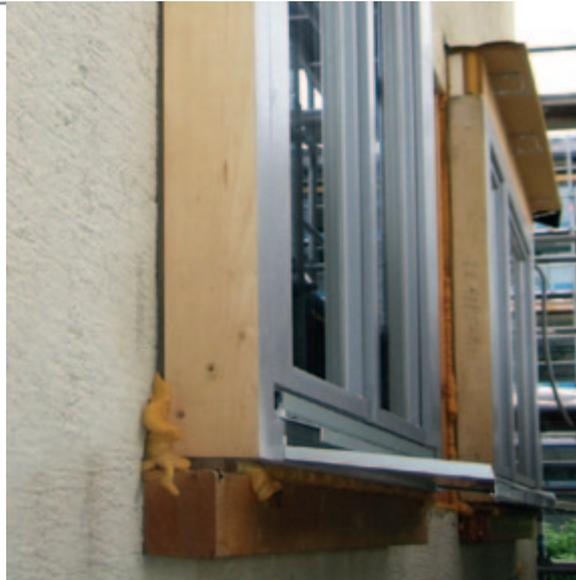
Ein Fenster gehört, wenn die Wand gut gedämmt wird, in die Dämmebene. Damit vermeidet man Wärmebrücken und tiefe Fensterlaibungen.
