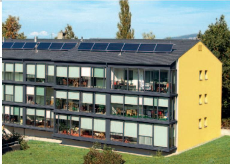
Mit neuer Balkonverglasung, neuen Fenstern, Dämmung und Solaranlage um den Faktor 10 weniger Energieverbrauch.
