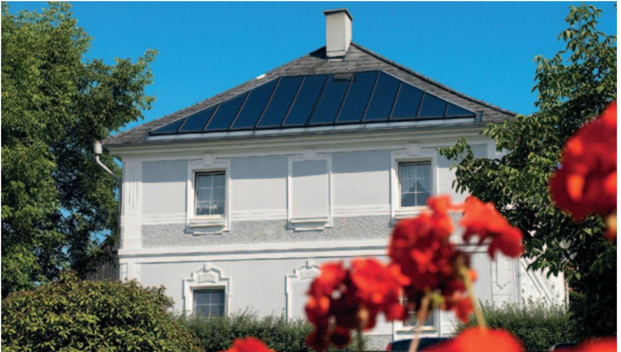
Für jedes Dach gibt es die passende Solaranlage. Orientierung und Neigung haben nur einen geringen Einfluss auf den Solarertrag.
