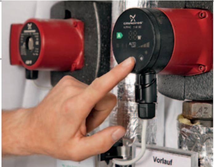
Hocheffiziente Umwälzpumpen benötigen nur mehr ein Siebtel der Energie einer alten Pumpe. Sie werden von jedem namhaften Hersteller angeboten.
