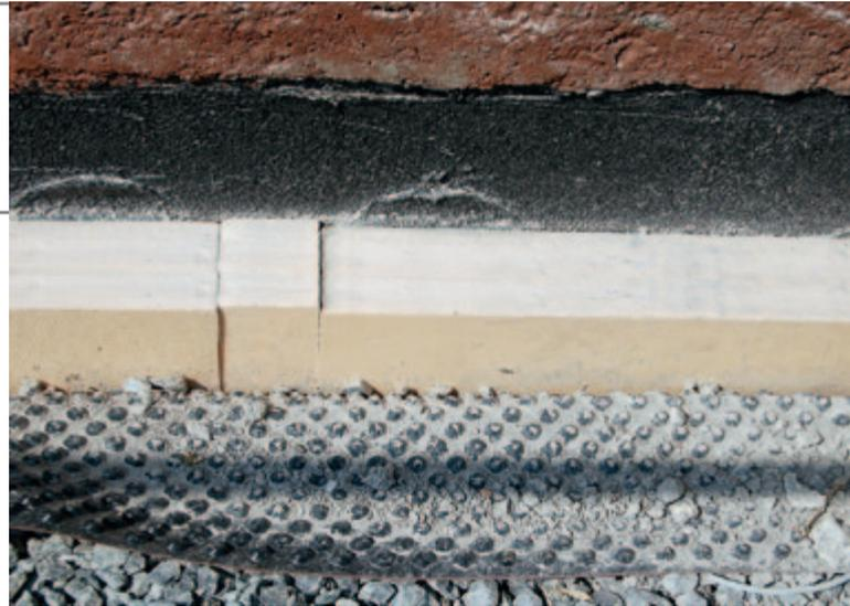
Das nachträgliche Dämmen von erdanliegenden Bauteilen auf der Außenseite ist aufwendig. Wenn aus anderen Gründen aufgegraben wird, sollte man die Gelegenheit nützen, um kräftig zu dämmen.
