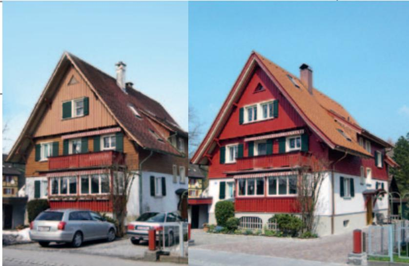
Vorher (links) und nachher: Mit einer Komfortlüftung, 18 cm Dämmung und Passivhausfenstern in die Förderstufe 4.
