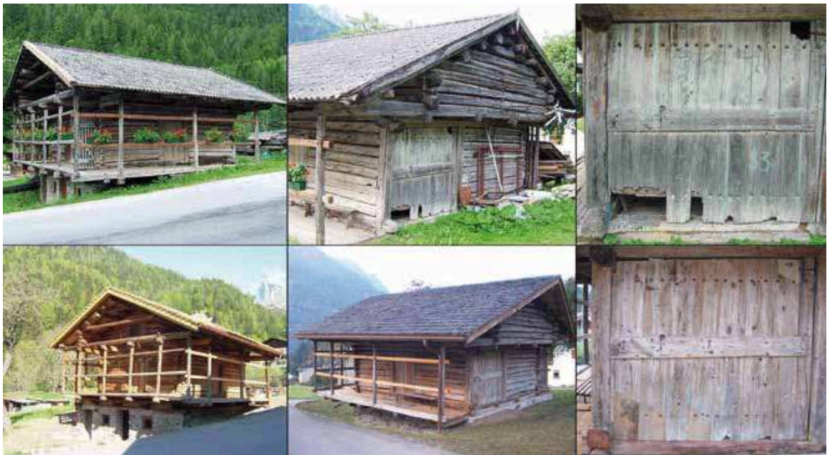
Foto prima dell'intervento (sopra) e dopo l'intervento (sotto)
