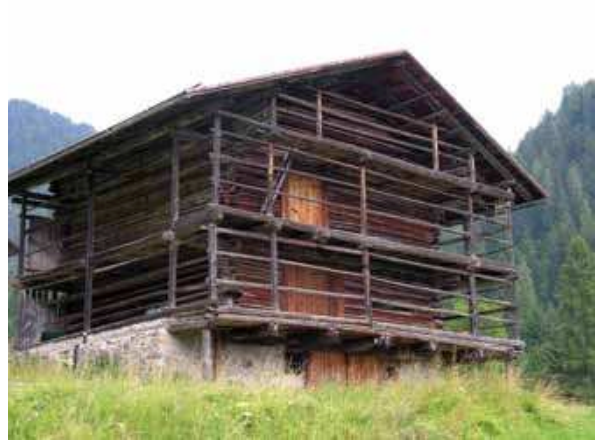
Blockbau in Andrich, Valle del Biois (Veneto)
