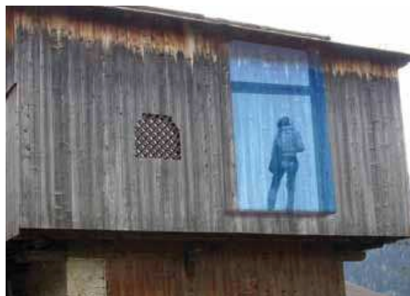
Gruppo di lavoro “Bed & Breakfast” particolare dello studio vetrazione del sistema bow window per l’illuminazione e l’aerazione dei locali interni – fotomontaggio.
