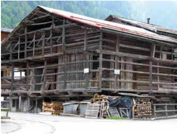
Rustico in blockbau con "palanzin", Canale d'Agordo (BL)
