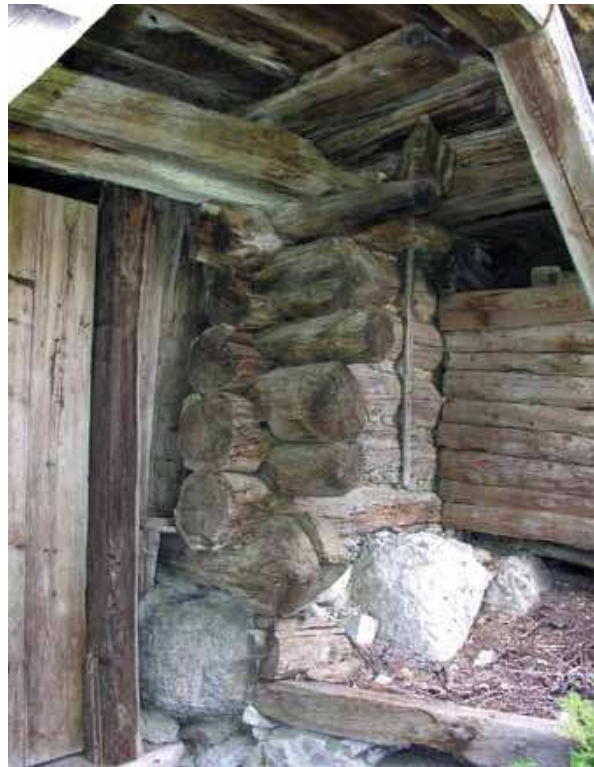
Blockbau particolare, Vallada Agordina (BL)
