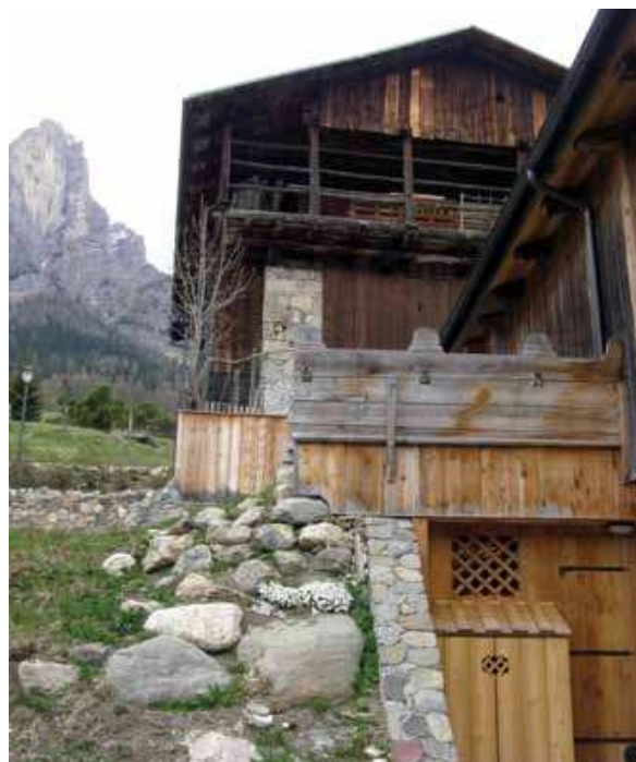
Fronte sud dell'edificio dopo il restauro
