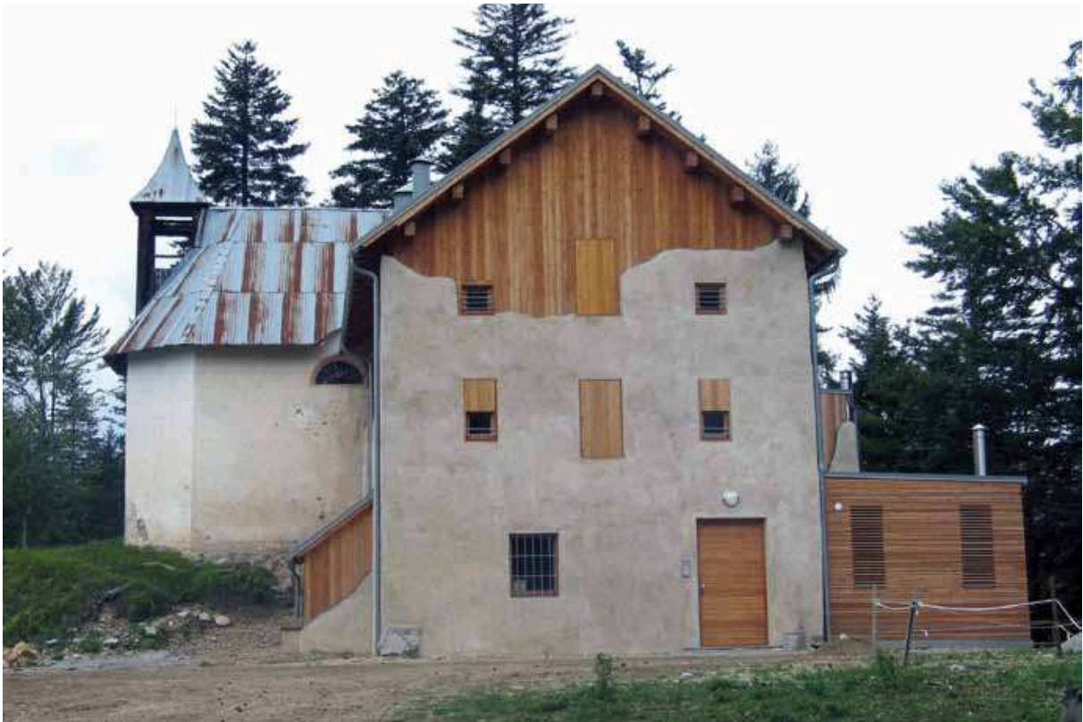
Restauro della chiesa di Santa Fosca, Selva di Cadore (BL)
