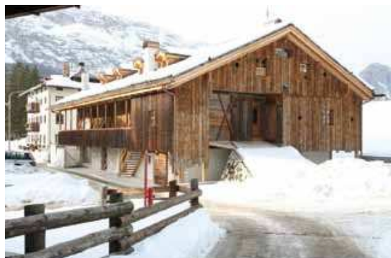
Esterni dopo l'intervento
