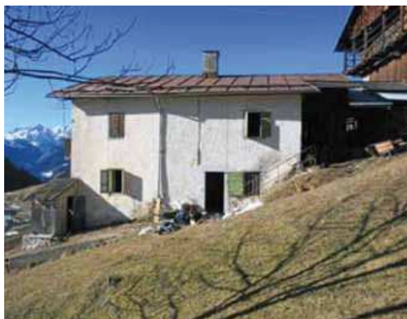
Fronte est dell'edificio prima del restauro
