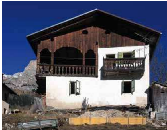
Fronte sud dell'edificio prima del restauro
