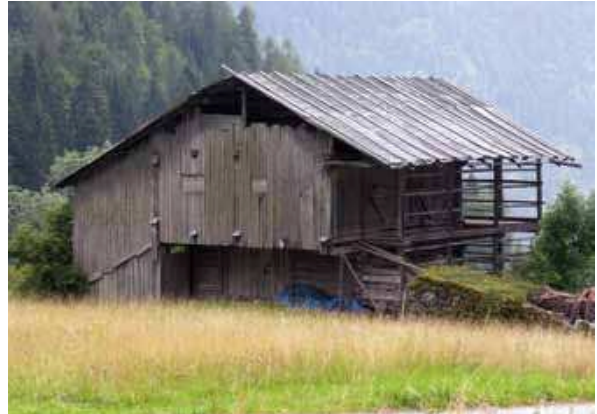
Tabià misto blockbau e assito con palanzin a Sacchet di Vallada Agordina (BL)
