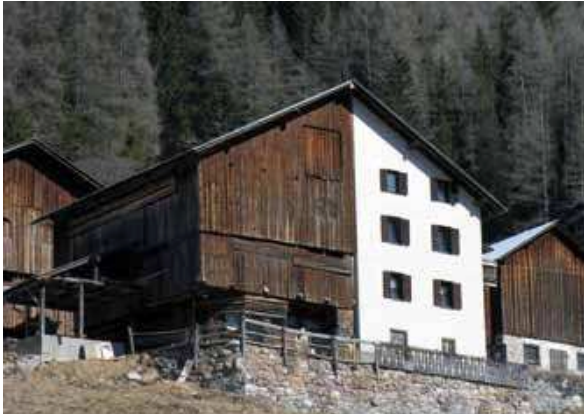
Casa Fodoma a Laste di Sopra, Comune di Livinallongo del Col di Lana (BL)
