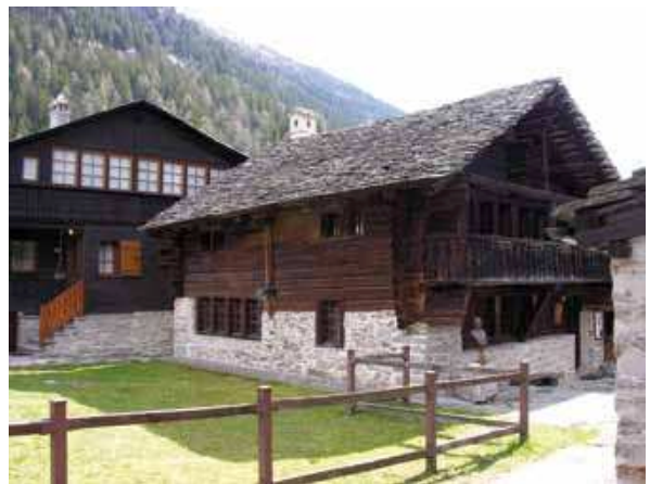
Casa Walser in Blockbau squadrato, Macugnaga (Piemonte)
