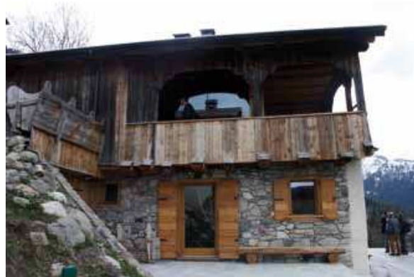
Fronte ovest dell'edificio dopo il restauro
