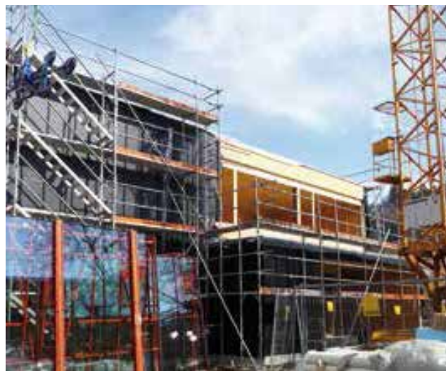
Baufortschritt Kindergarten Muntlix
