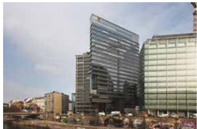
Der weltweit höchste PassivhausZubau steht am Donaukanal in Wien.
