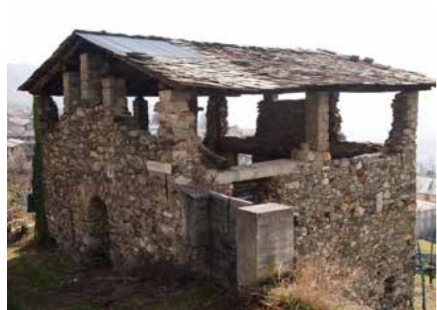
Struttura in pietra e piode a Ponte in Valtellina Foto: Alessandra Gelmini
