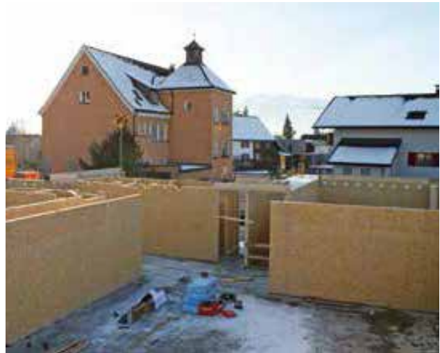
Baufortschritt Kindergarten Muntlix
