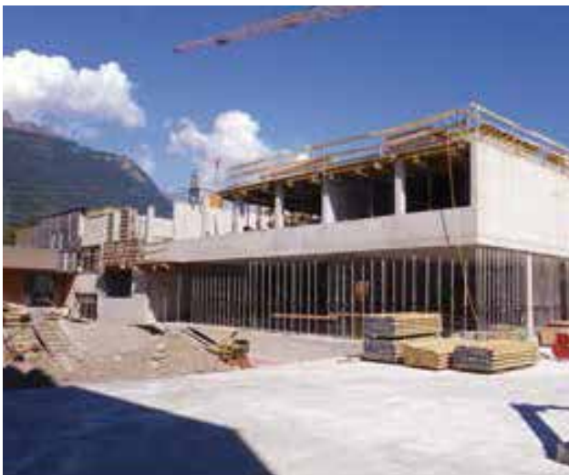
Baufortschritt Mittelschule Bürs
