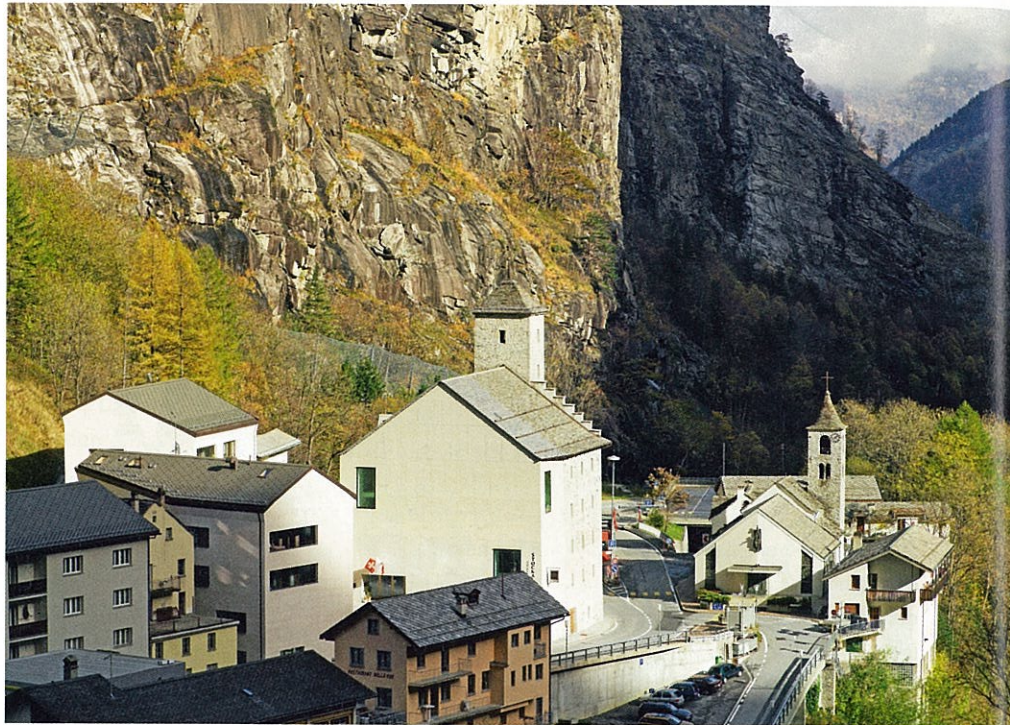
Wiederaufbau, Gondo, Wallis, Schweiz
